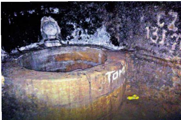
У подземном делу тврђаве је и бунар за снабдевање питком водом
